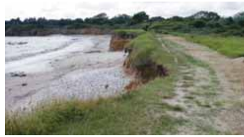
Erosion du sentier littoral à Bédume, Ambon.
